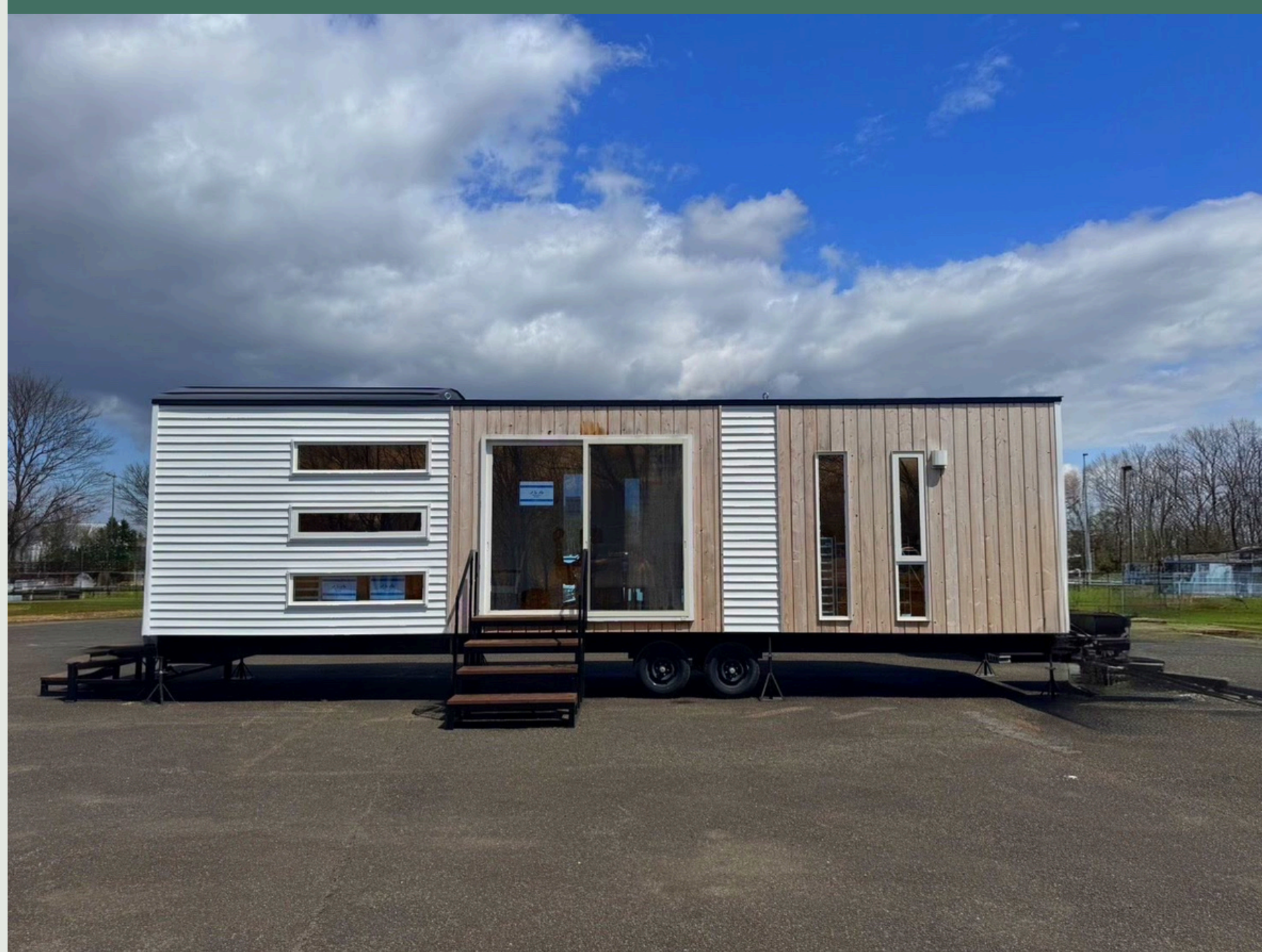
トレーラーハウス
